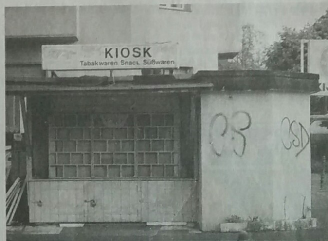
Verfallener Kiosk an der Remigiusstraße in Sülz
